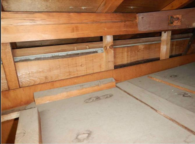
備考 天井裏面の水染み跡・釘からの結露の可能性もあるが、雨漏りの可能性も有り
