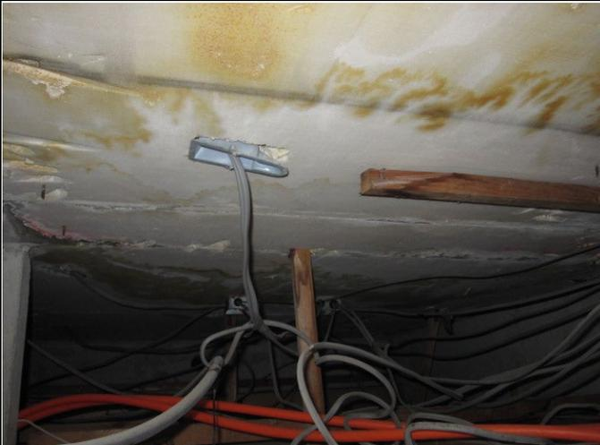
備考 天井裏面断熱材に水染み有り・雨漏りによる可能性有り
