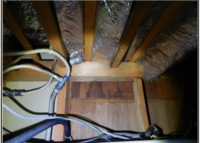
備考 ボードの水染み跡・給排水管からの漏水による可能性有り
