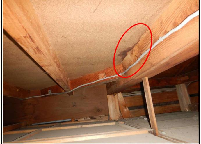
備考 天井裏の写真：床下地板及び梁の水染み跡・雨漏りの可能性有り
