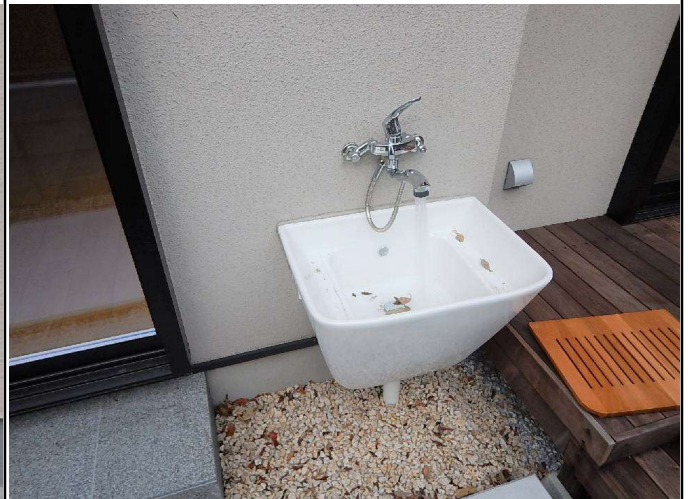
備考 水栓回りの防水未処置 写真1参照
